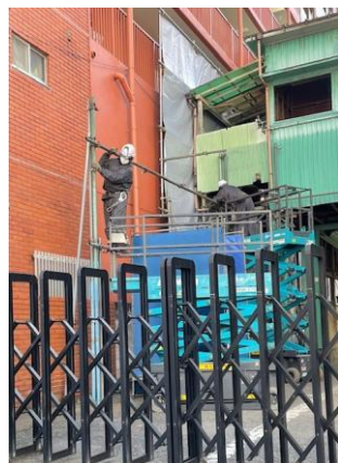
隣との境界に慎重に足場を組む作業員ら
