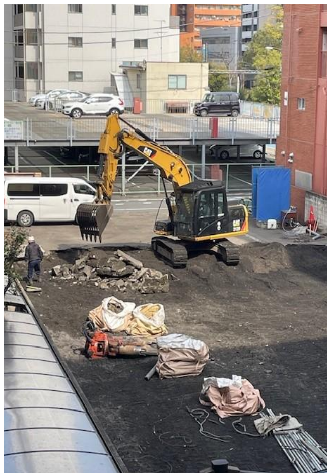
既存の建物は跡形もなくなり、コンクリートやアスファルトの撤去作業が始まっている様子
