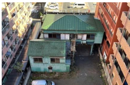
解体前の建物(自動車修理工場跡)
