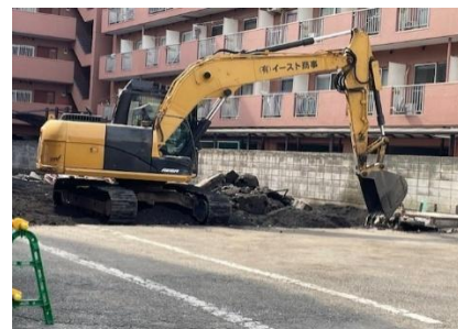
コンクリートの床を崩すキャタピラー油圧式ショベル
